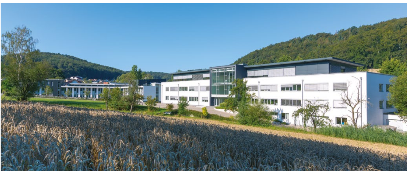
Die Firmenzentrale der REA Elektronik GmbH, 30 km südlich von Frankfurt am Main
